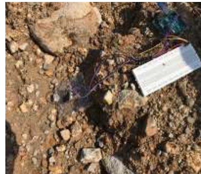
Gambar 13. Sensor Accelerometer Kondisi Tidak Normal pada Tanggul Lapindo
